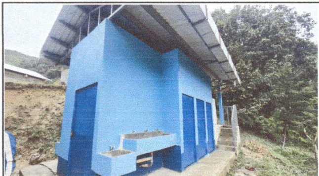
Foto1: Luego de haber realizado los diferentes procesos de instalacion de piso ceramico
