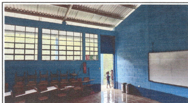
Foto 4: Se observa la finalizacion de aplicación de pintura interior del aula II
