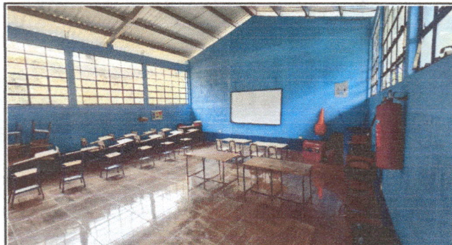
Foto 2: Se evidencia el proceso realizado en instalacion de piso ceramico
