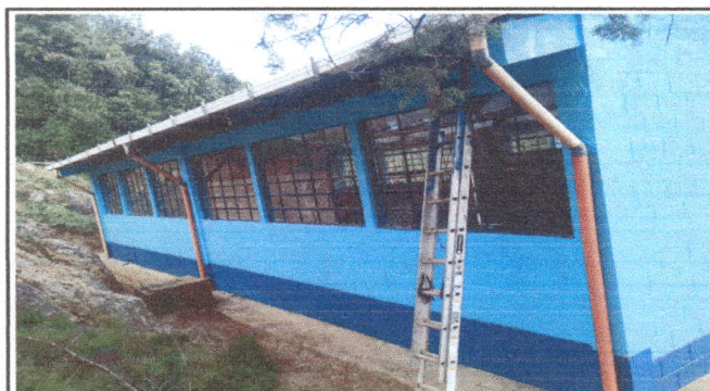
Foto 3: Se evidencia la finalizacion de diferentes procesos de mantenimiento de edificios escolares, aplicación de pintura y instalacion de canales
